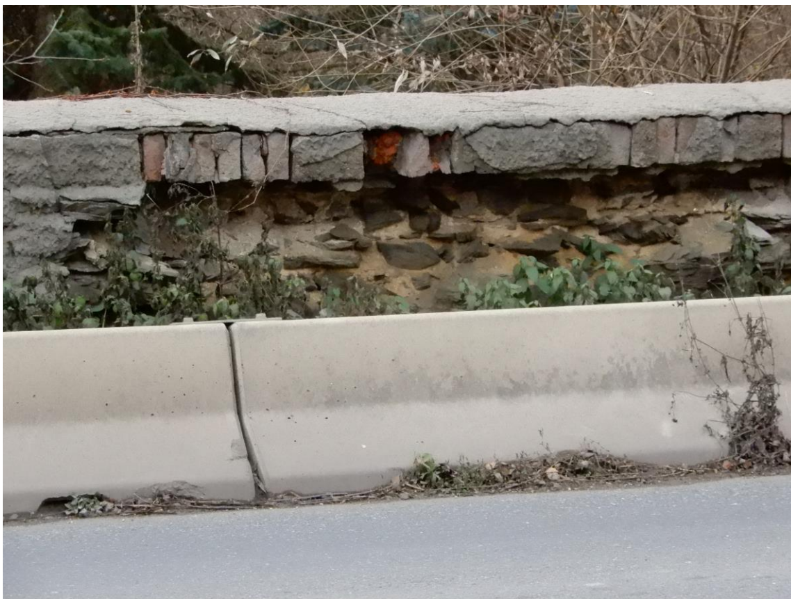
Totálně rozpadlá parapetní zídka opěrné zdi
