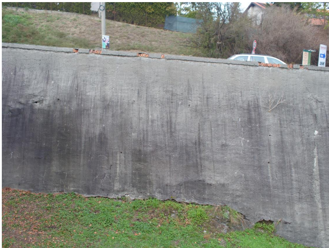
Severní část zdi -torkretový plášť
