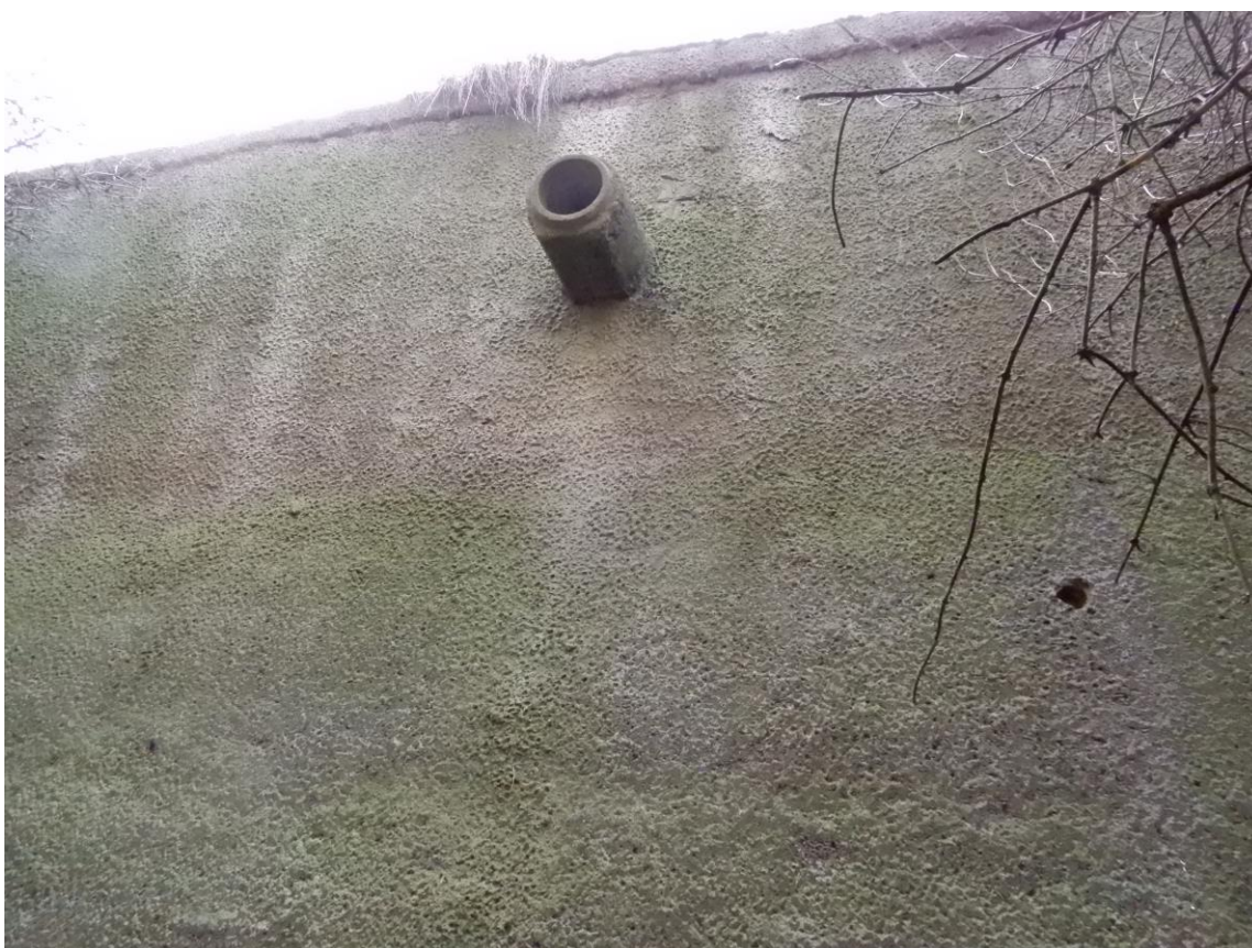
Nefunkční odvodňovač
